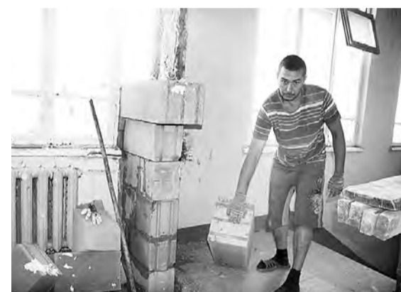
Для кладки используется сибит-легкие газобетонные блоки.
