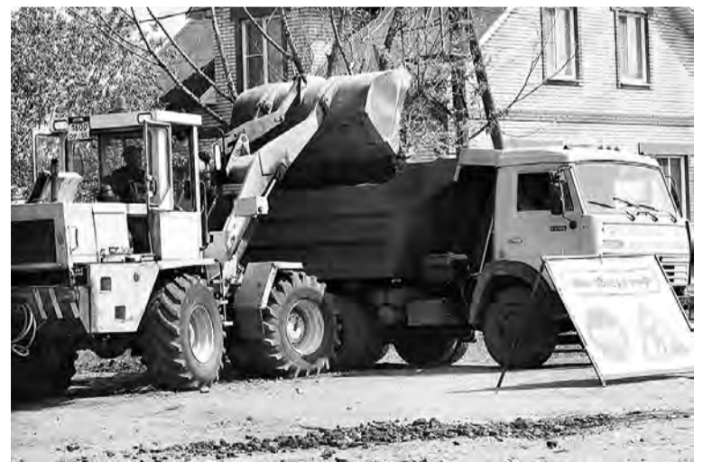
На улице Национальная в Марьяновке начался ремонт автодороги.
