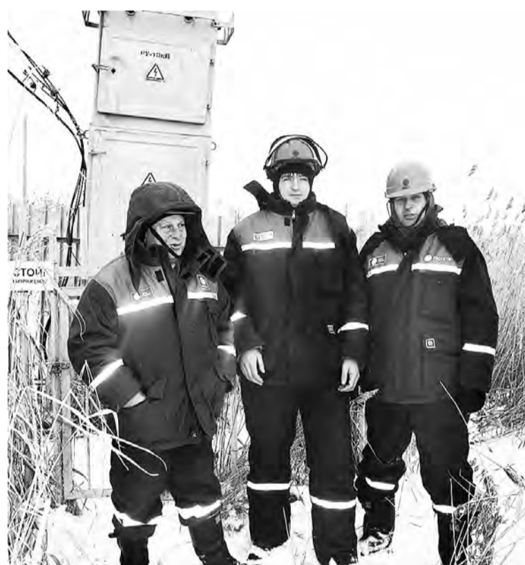
Бригада электромонтеров из п. Конезаводский.
