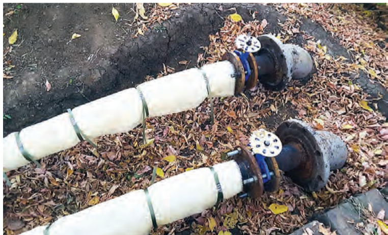
Летняя работа: замена тепловой сети в пос. Москаленский.
