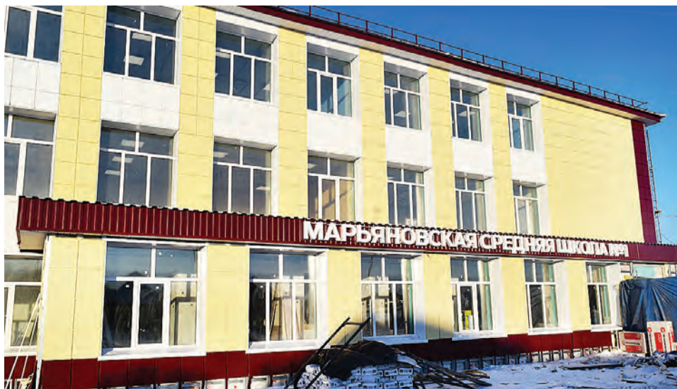
Капитальный ремонт в МСШ №1 близится к завершению.
