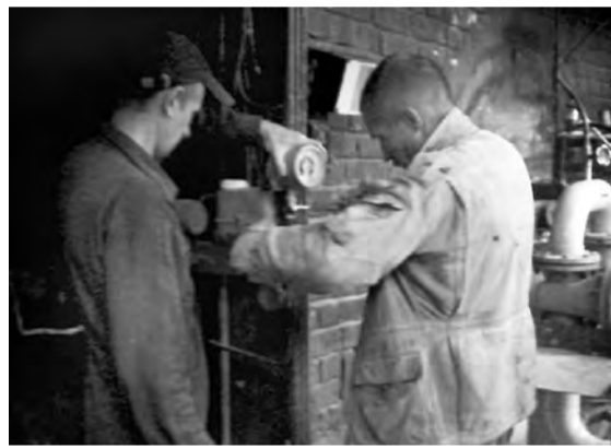
Слесари Дмитрий Вакиш и Андрей Коханец устанавливают приборы на котлы в центральной котельной.
