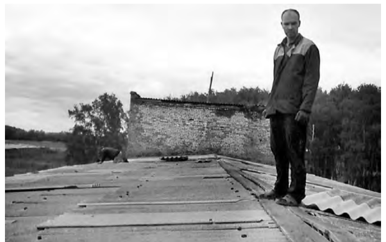
В числе рабочих, ремонтирующих кровлю Шараповской котельной, Руслан Челак.
