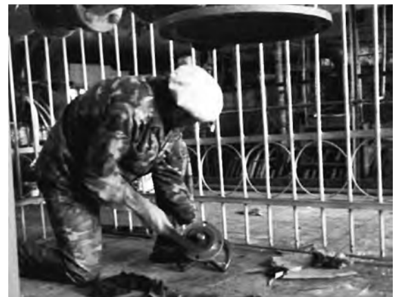
Ремонт запорной арматуры ГРУ: слесарь Александр Рудак.
